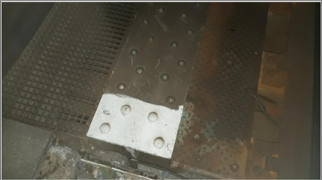
Bild: 1: Probe 001, Anstrich Überbau
